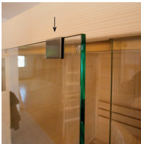
Přiložení plastových příložek u rukojetí z nerezové oceli
