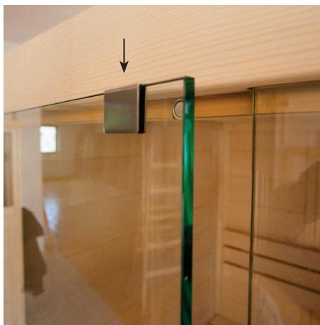
Kunststoff-Beilagscheiben bei Niro-Griff beilegen
