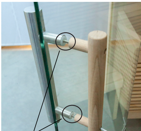
Přiložení plastových příložek u rukojetí z nerezové oceli
