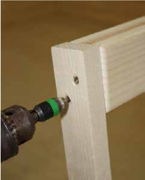
Transportleiste vom Türstock entfernen
