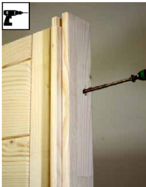
8 vis 6 x 120 mm par montant d'angle
