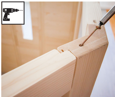
Punta per trapano da 3 mm, 1 vite 4 x 70 mm
