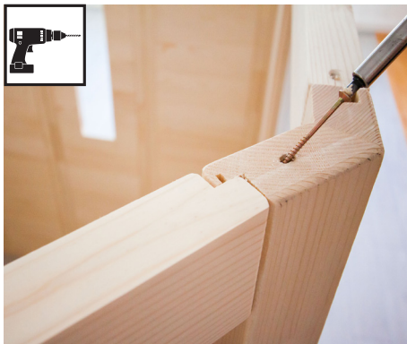
Broca de 3 mm, 1 parafuso de 4 x 70 mm
