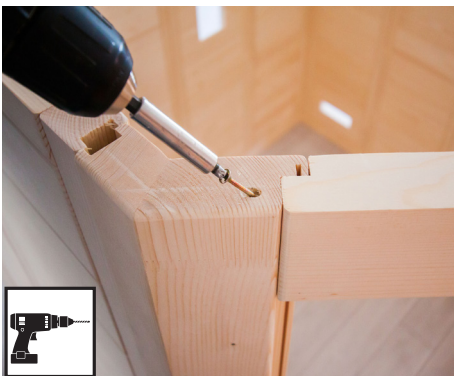
Broca de 3 mm, 1 parafuso de 4 x 70 mm
