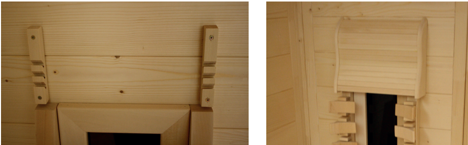
Fig. 49: Montagem dos apoios de cabeça
