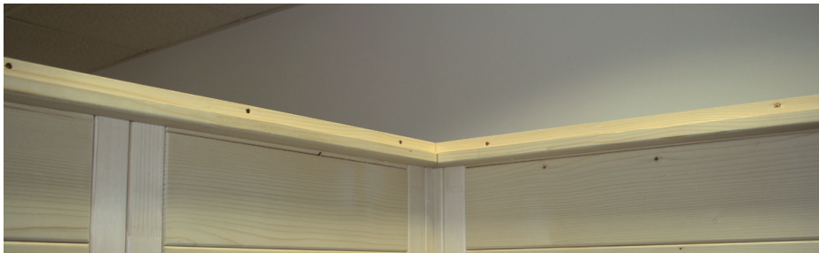
Afb. 17: Plaatsen van dakelement achter met ventilatoruitsparing
