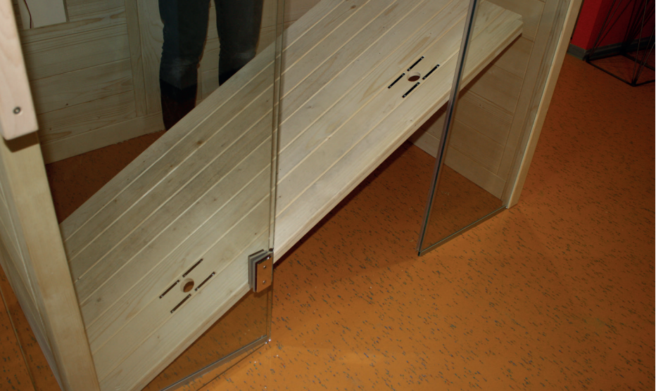
Fig. 27 : Poser le plancher de la cabine
