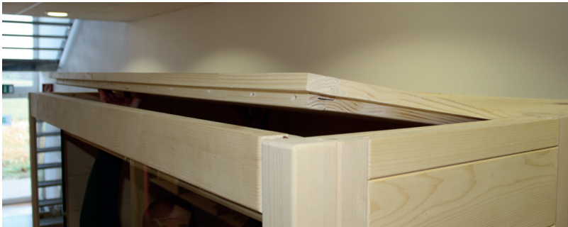
Abb. 18: Einlegen Dachelemente vorne
