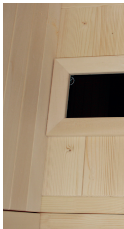
Fig. 38: Montaggio della mascherina degli irradiator posteriori
