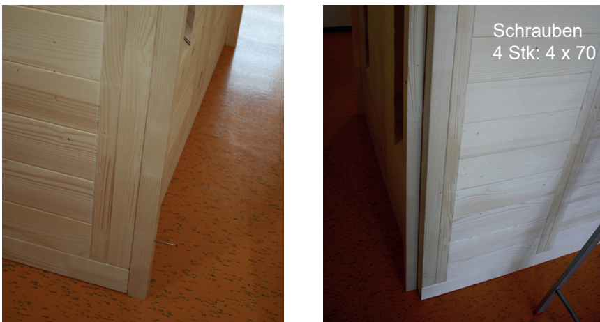
Abb. 47: Montage Abstandleisten Rückwand
