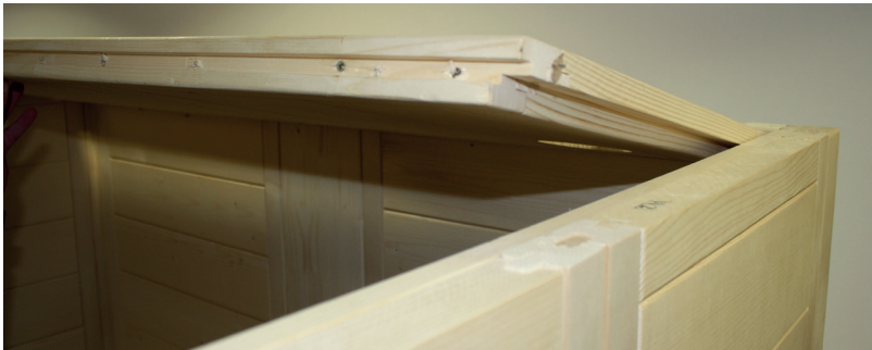
Abb. 18: Einlegen Dachelemente vorne
