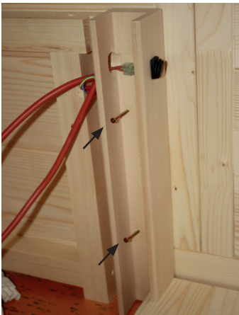
Fig. 33: Montagem das barras em U para placas de aquecimento
