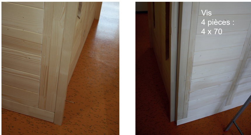
Fig. 47 : Montage des barres d'écartement paroi arrière
