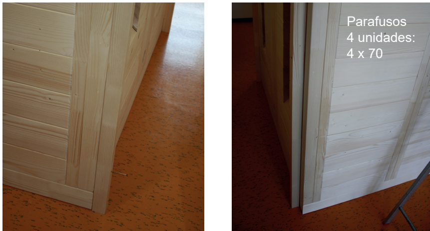
Fig. 48: Montagem das barras distanciadoras na parede traseira
