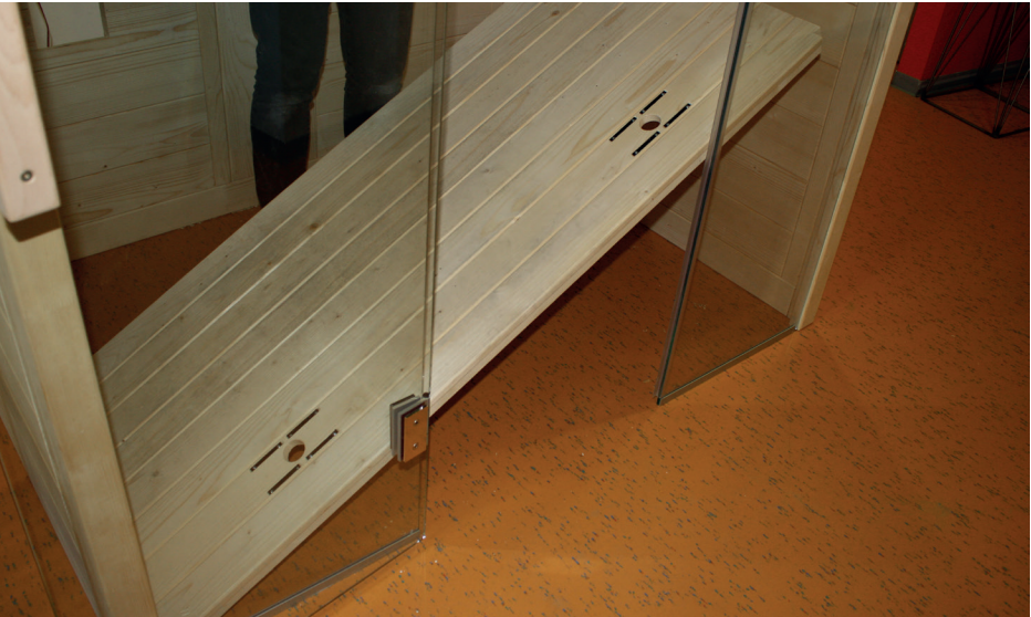
Fig. 27: Inserimento del pavimento della cabina
