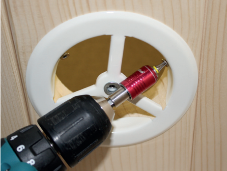
Abb. 35: Montage der Entlüftung
