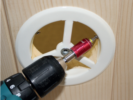
Fig. 36: Montagem da ventilação
