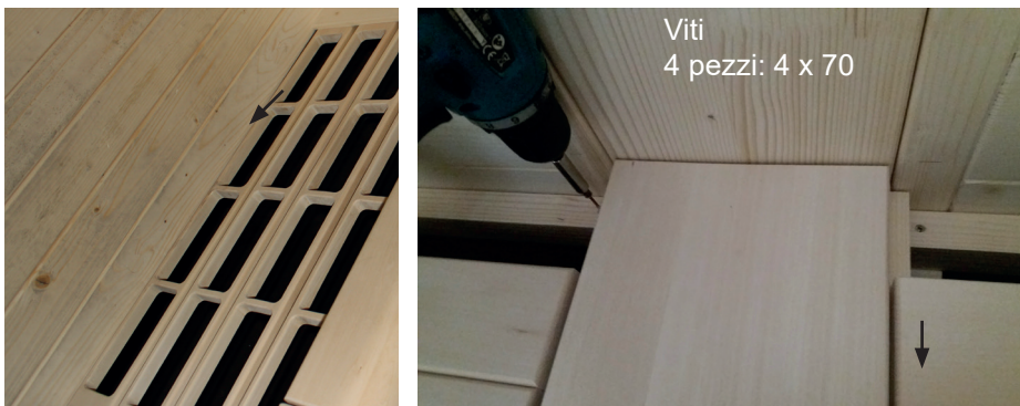
Fig. 46: Fissaggio della panca
