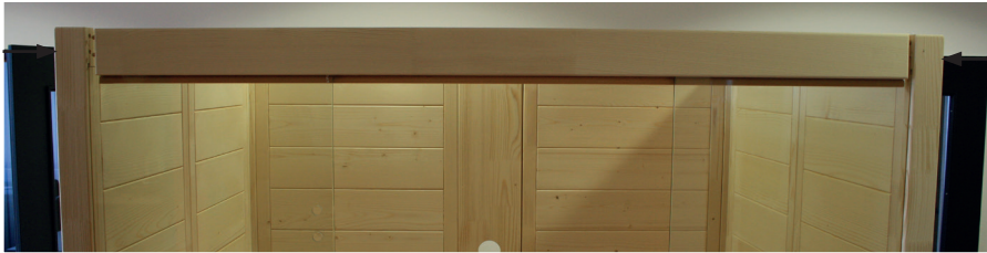
Fig. 15: Fixação da barra maciça
