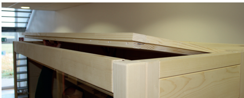
Fig. 18: Inserimento dell'elemento tetto anteriore
