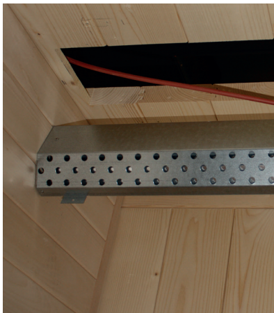
Fig. 37: Montaggio degli irradiator posteriori (irradiatore a infrarossi ECO 350)
