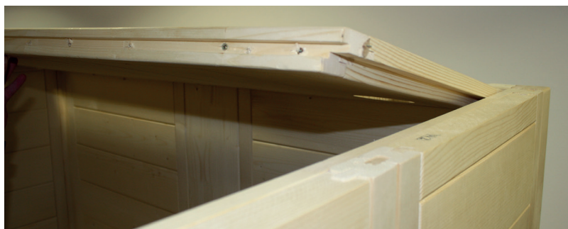
Afb. 18: Plaatsen van dakelementen voorzijde
