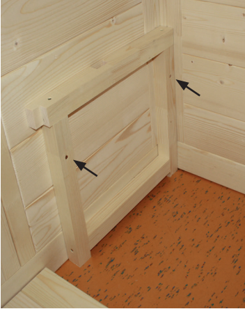
Fig. 31 : Montage du support du banc
