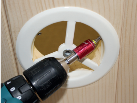
Fig. 35: Montaggio della ventilazione
