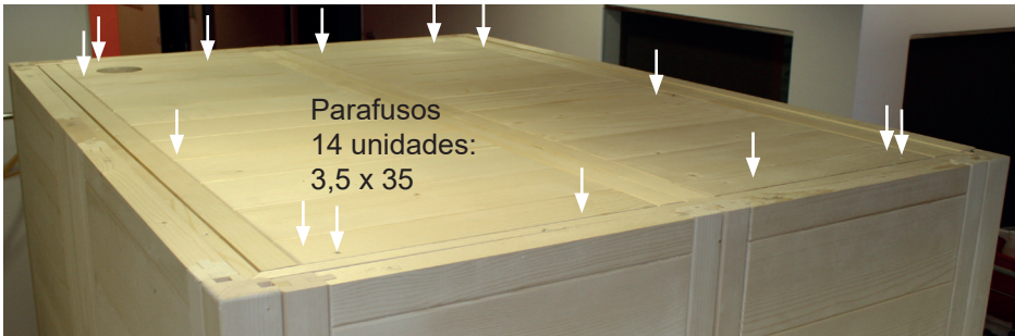
Fig. 19: Fixação dos elementos de teto
