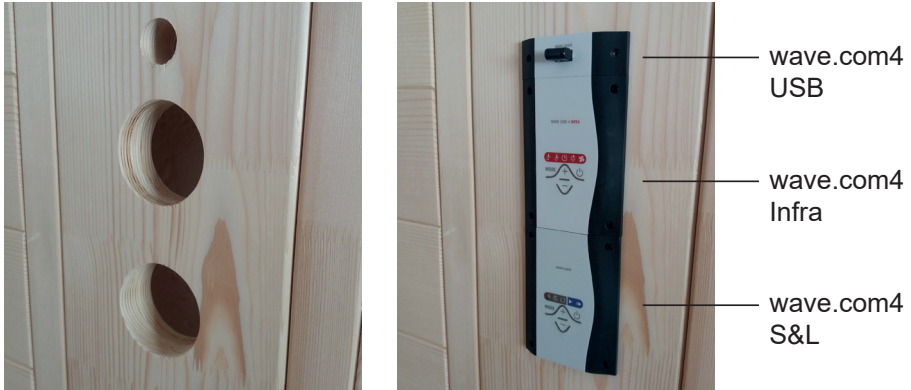
Fig. 45: Montagem da unidade de comando
