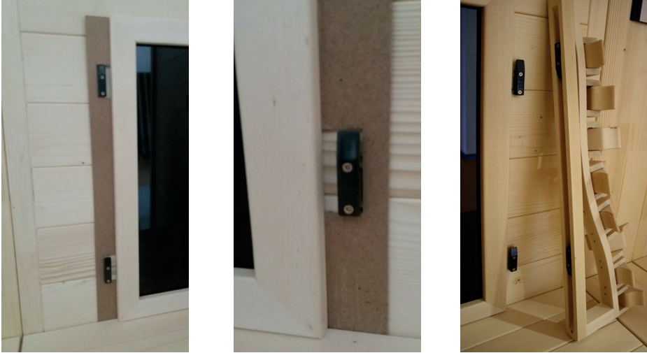
Fig. 50: Montagem dos encostos
