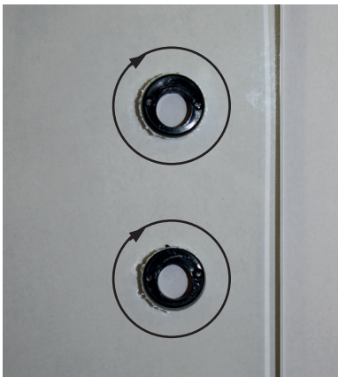
Fig. 22: Montagem das ferragens da porta 1
