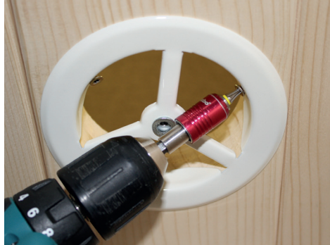
Fig. 35 : Montage de la ventilation
