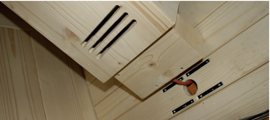
Fig. 28 : Fixer le radiateur avant
