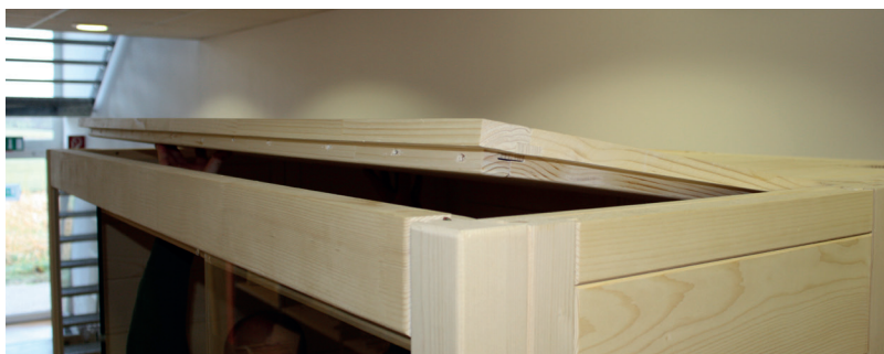
Fig. 18 : Insertion de l'élément de toit avant
