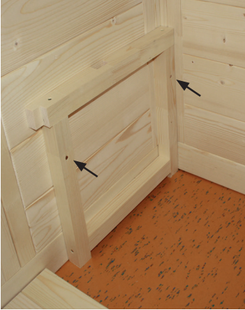
Fig. 32: Montagem do apoio do banco
