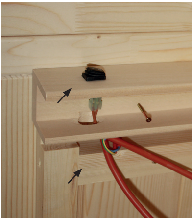
Fig. 32: Montaggio dei listelli a U per i pannelli radianti
