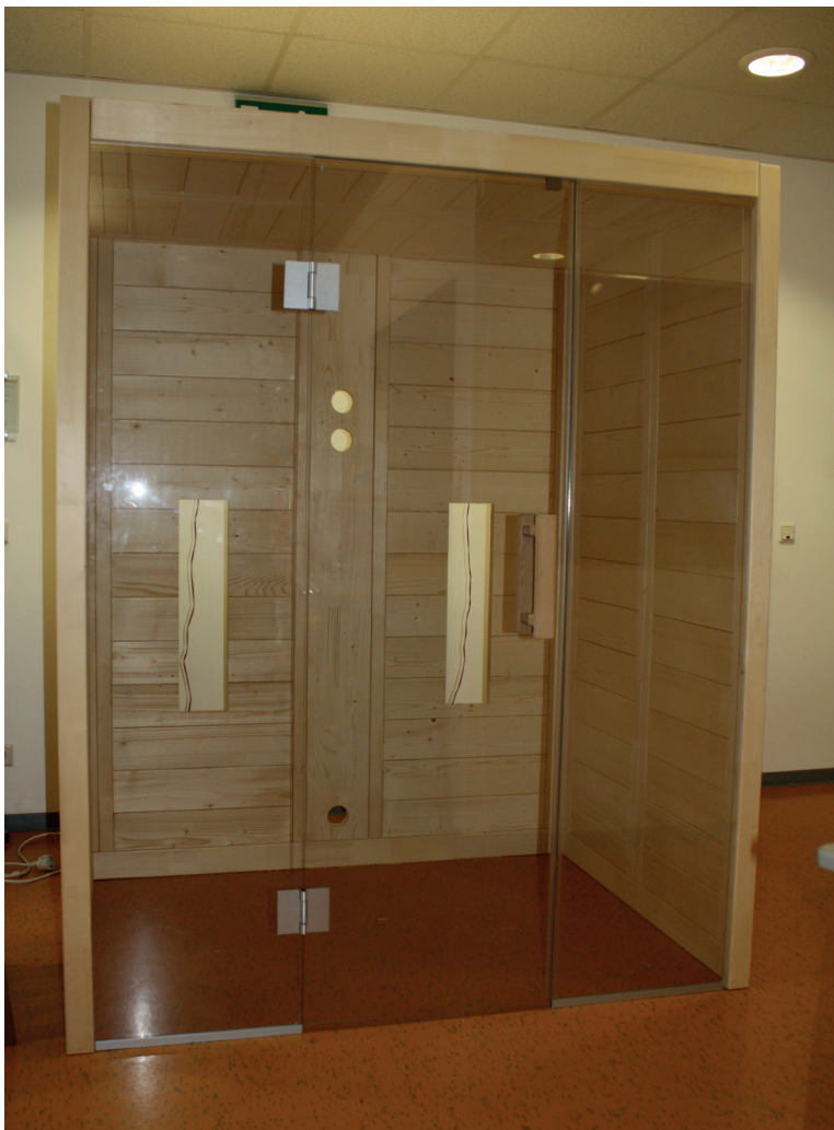
Fig. 26: Paredes da cabina e elementos de teto concluídos
