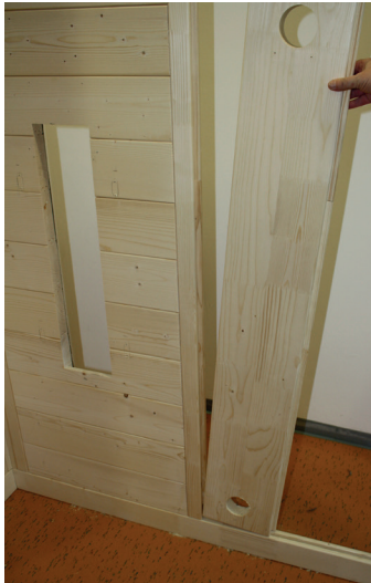
Fig. 6 : Insérer l'élément électrique
