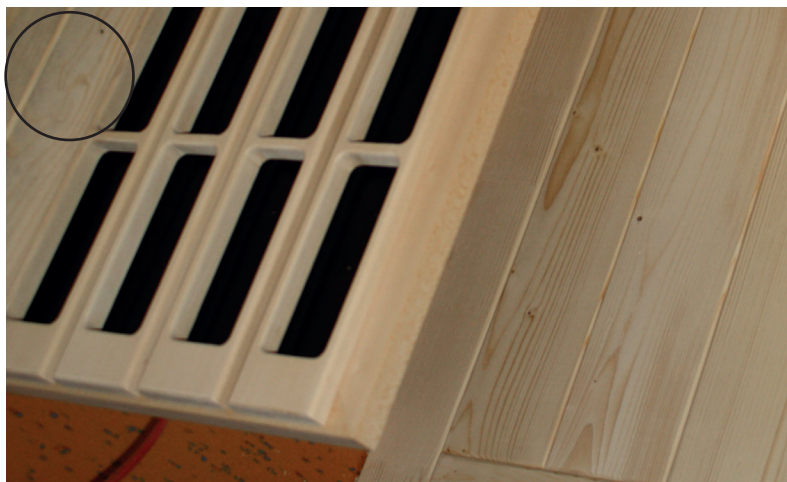
Fig. 33: Inserimento del pannello radiante IR VitaMy 164
