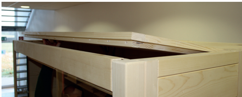
Afb. 18: Plaatsen van dakelementen voorzijde
