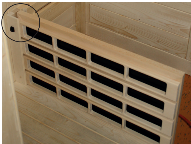
Fig. 34: Instalação da placa de aquecimento por IV VitaMy 164
