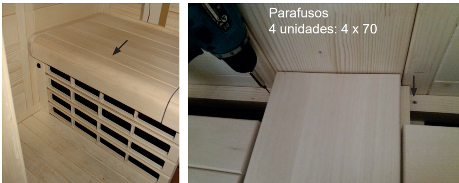
Fig. 47: Fixação do banco
