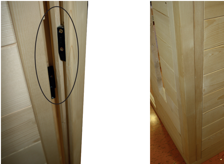
Fig. 4: Unir os elementos de parede aos suportes de canto
