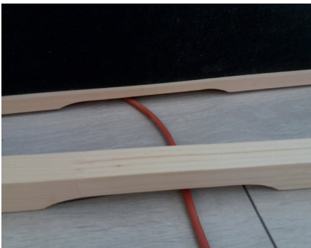
Abb. 34: Einsetzen der Aussteifungsleiste für IR-Wärmeplatten VitaMy
