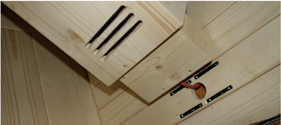
Fig. 28: Fissaggio degli irradiator anteriori
