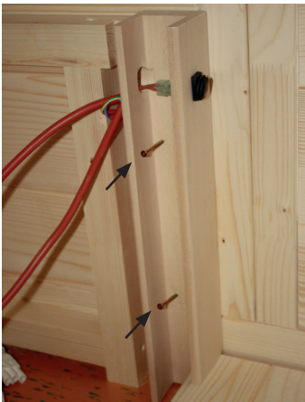
Fig. 32 : Montage des barres en U pour les plaques chauffantes
