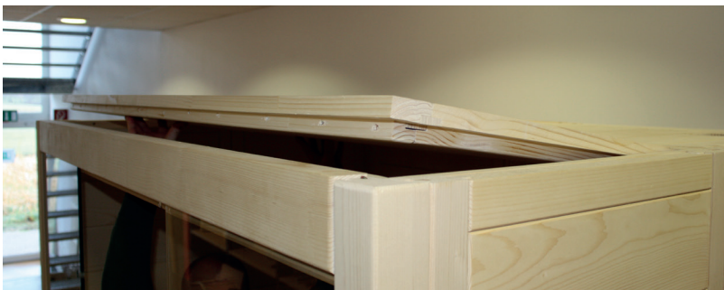
Fig. 18: Inserção dos elementos de teto da frente
