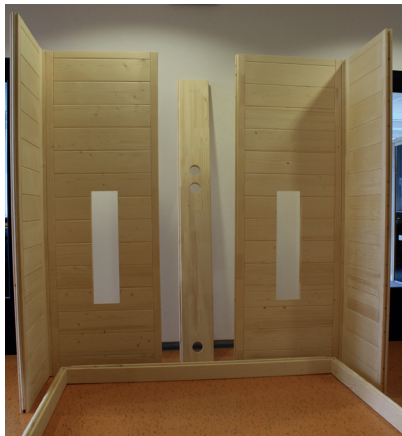
Fig. 5: Montagem na armação do chão
