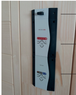
Fig. 44 : Montage du panneau de commande
