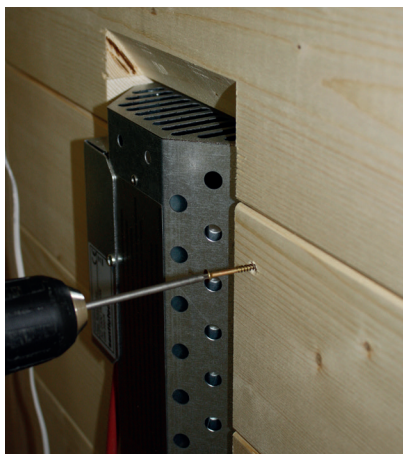
Fig. 38 : Monter le cache du radiateur arrière
